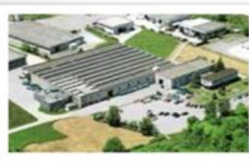
Sprzęt budowlany, San Gimignano (Siena), Włochy
