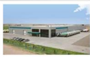
Maszyny betonowe (mieszarki samochodowe) Aksaray, Turcja
